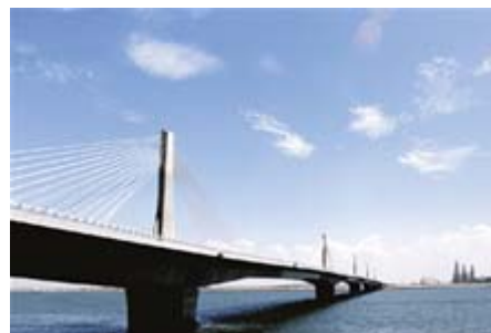
第二名神高速公路揖斐川桥西上部桥桁工程
