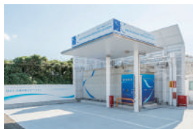
MKK川崎水素ステーション
