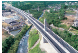
新名神高速道路 菟野第二高架橋
